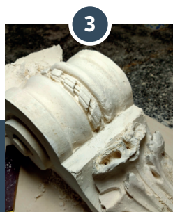
3 Rénovation des éléments en plâtre.
