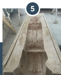
5 Fabrication d'un moule en élastomère sous une chape en plâtre.
