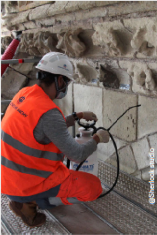
Pulvérisation en surface
