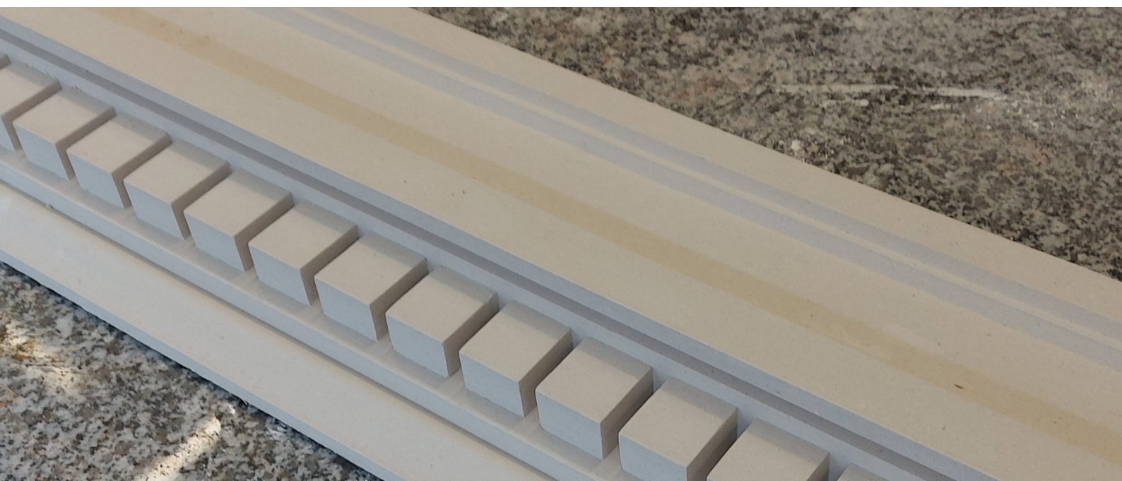
Corniche à denticules réalisée en plâtre chaux blanc fibré, maintenue par une armature en staff.
