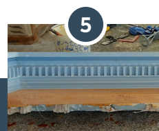
5 Fabrication d'un moule en élastomère de l'ensemble de la corniche.
