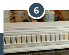
6 Fabrication d'une corniche à denticules en plâtre chaux blanc fibré, maintenu par une armature en staff.
