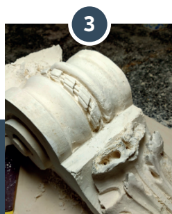
3 Rénovation des éléments en plâtre.
