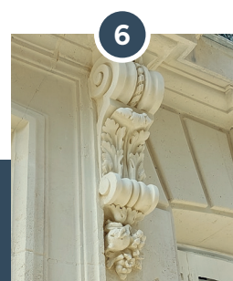
6 Installation sur chantier de la console en stuc pierre.
