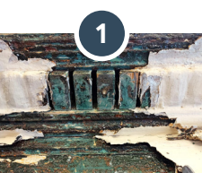
1 Récupération des éléments en bois, découpage de la corniche et formation du dessin en zinc.
